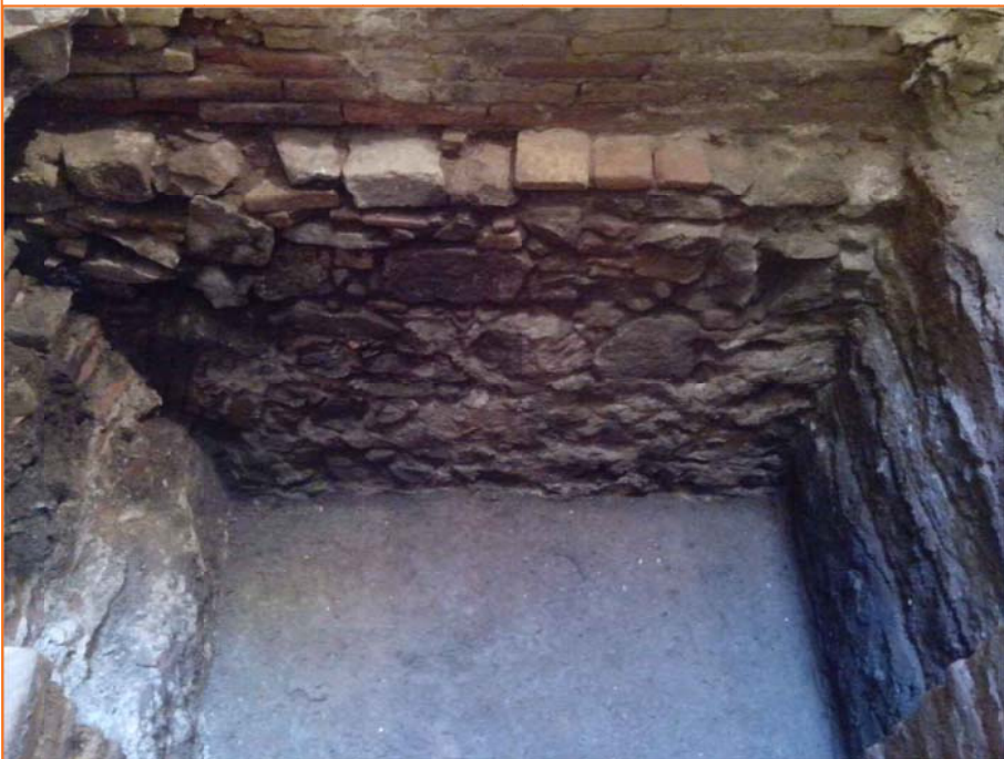
Foto 8. Detall del mur UE 6.
